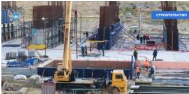
Рисунок 2 – Строительные работы второго этапа сооружения шлюза
